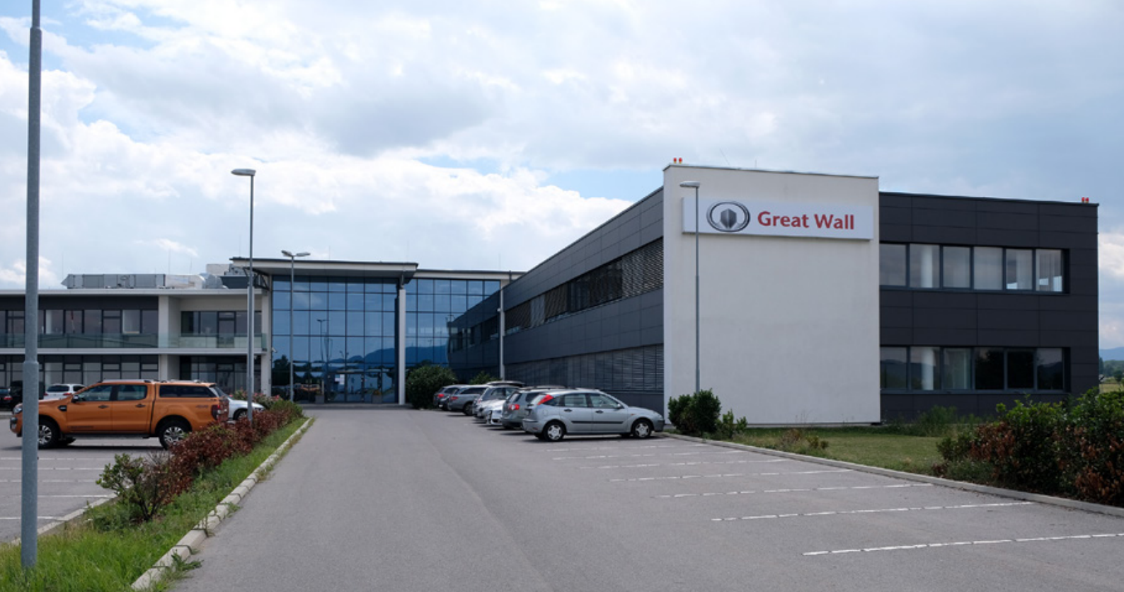
Standort Kottlingbrunn im Süden von Wien. Bild: GWM
